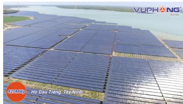
Hình 2. Nhà máy điện mặt trời Dầu Tiếng tại Tây Ninh (Source: Vũ Phong Solar)
