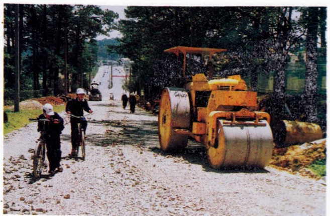
Nâng cấp đường phố Đà Lạt. Ảnh: HHN. Upgrading the streets of Dalat. Photo: HHN
