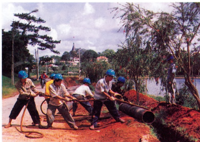
Nâng cấp đường ống nước sinh hoạt ở Đà Lạt.
