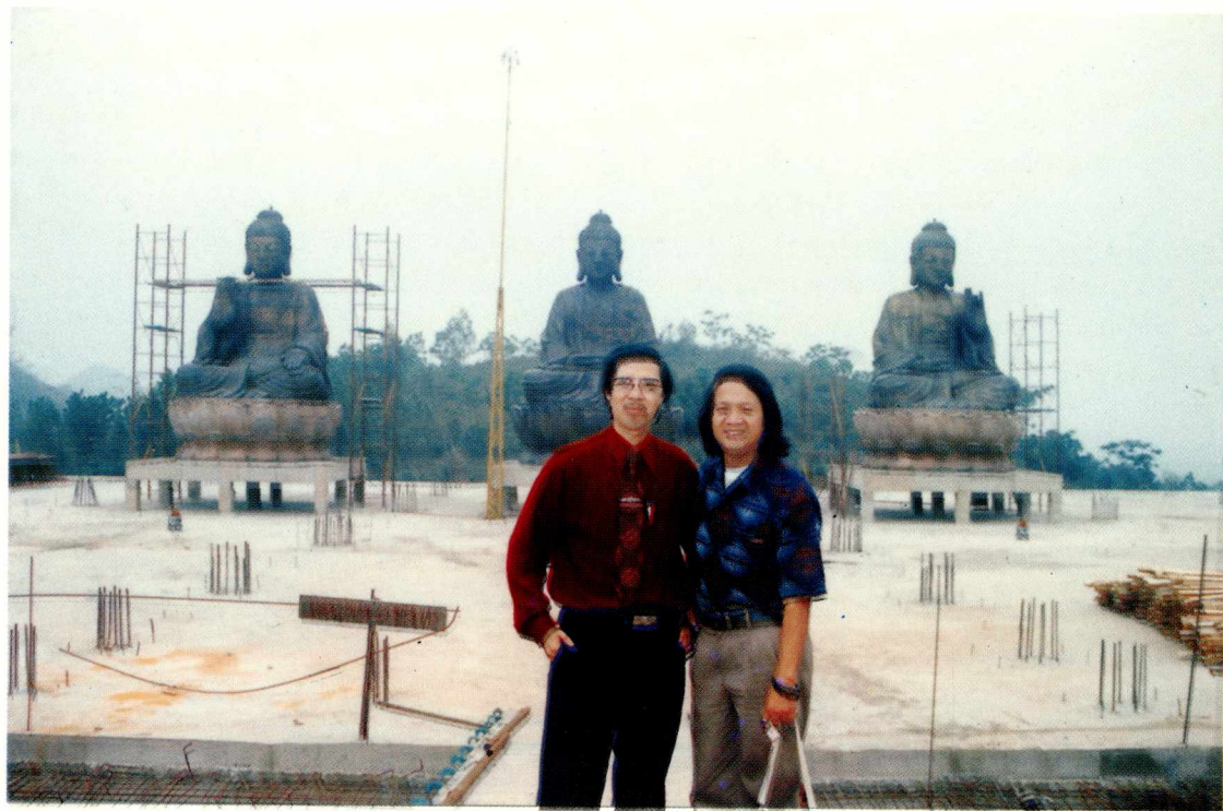
HS Anh Đức cùng Tác giả tại một khu chùa lớn đang xây dựng ở Ninh Bình
