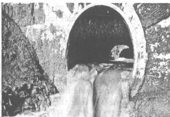
Hình 1.12. Xả nước thải vào nguồn nước mặt
