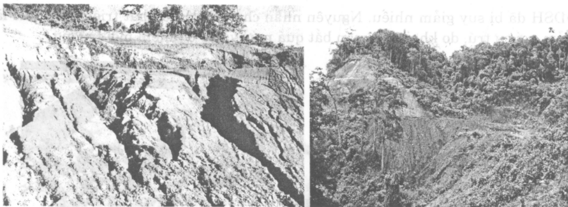
Hình 1.11. Sạt lở đất
