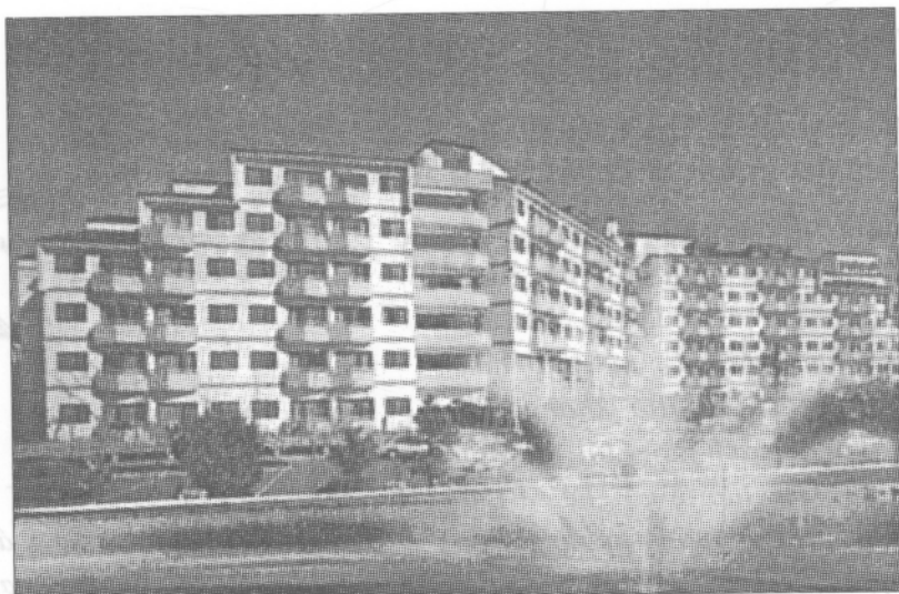
Hình 6: Phun hơi nước cạnh công trình
