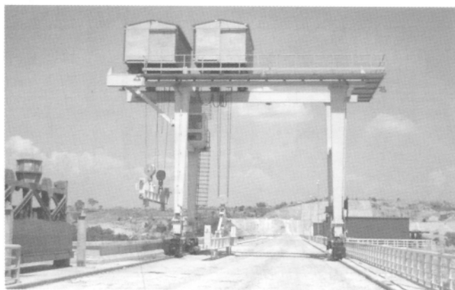
Cầu trục nhà máy thủy điện
