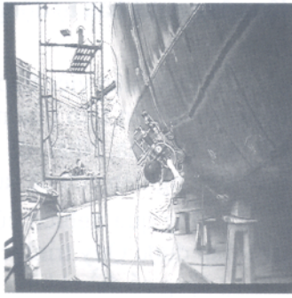
Hình 4: Lắp ráp đồ gá trên thành tàu.
