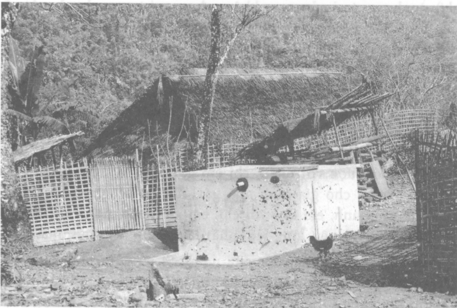
Công trình nước bơm tự chảy phục vụ đồng bào Si La. Ảnh: Tấn Vịnh
