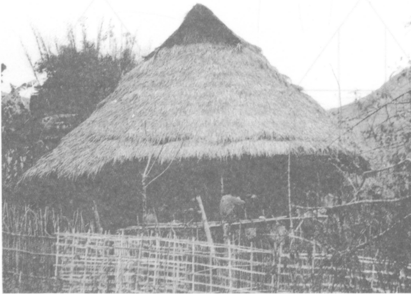
Đầu hồi nhà với rìa mái hình mai rùa.
