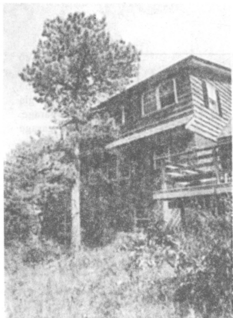
Hình 12.5 : Ngôi nhà vững chắc được xây dựng trên một sườn dốc. Chú ý nền nhà được xây cắm sâu vào dốc. Mặt tiền bằng gạch tạo nên dáng vẻ chắc chắn. Hãy so sánh ngôi nhà này với nhà ở hình 12.6.
