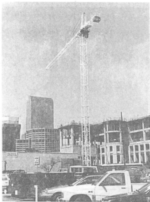
Hình 11.5D : Cần cẩu xây dựng.
