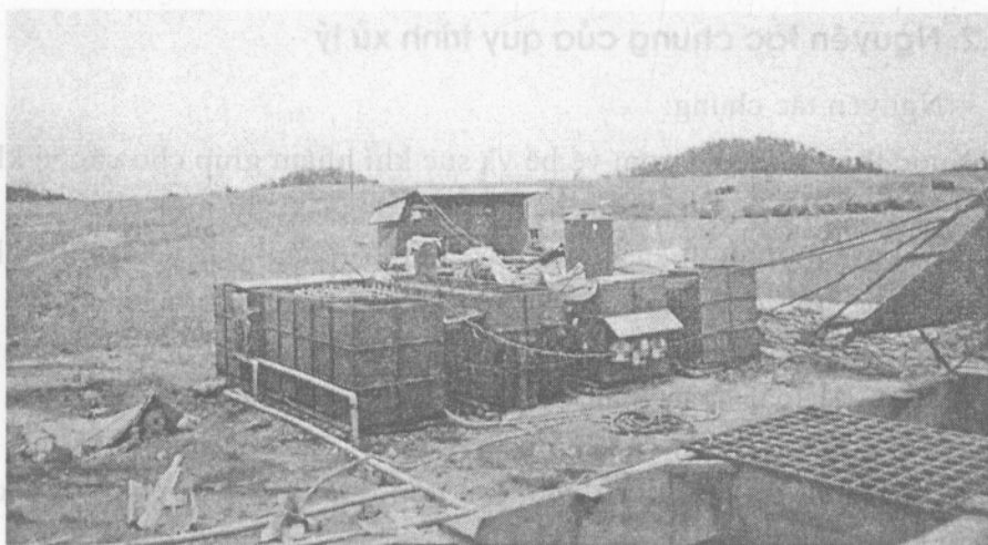
Hình 6.2. Trạm xử lý nước rác đã lắp đặt tại bãi rác Nam Sơn – Hà Nội
