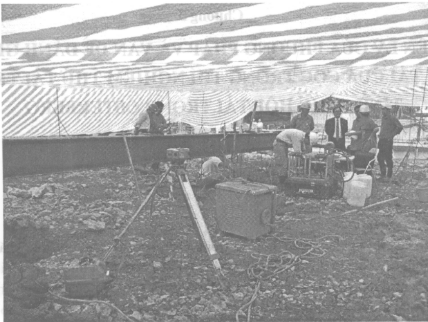
Hình 2. 2: Chất tải tĩnh cọc barrette bằng phương pháp HTT Osterberg tại công trình nhà cao tầng 27 Láng Hạ. Tải trọng thử 21,2 MN.
