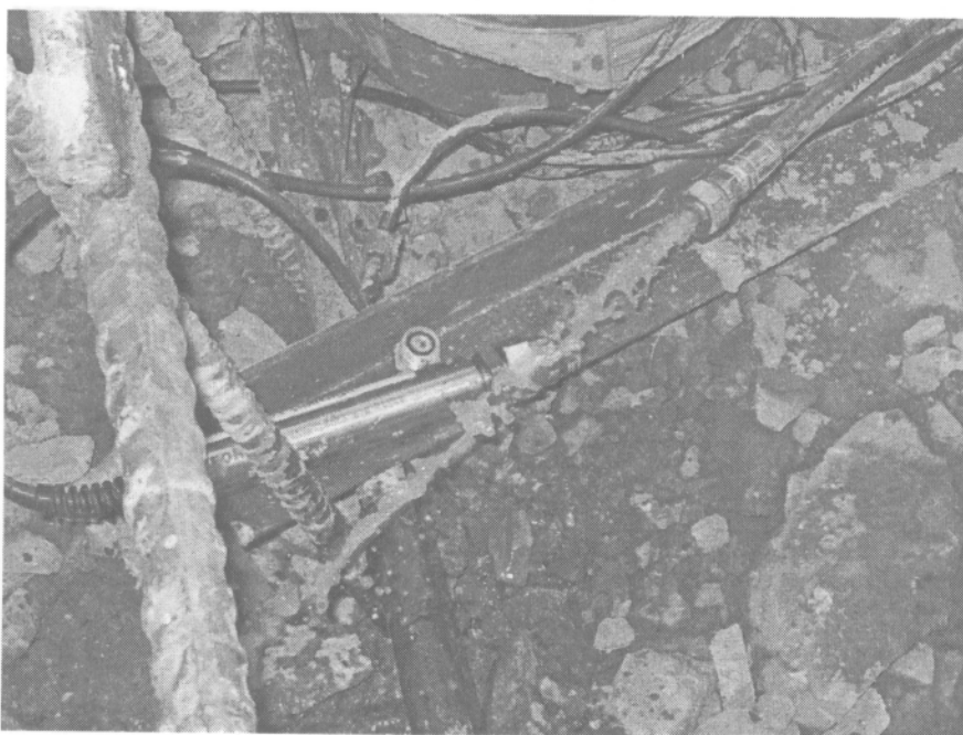
Hình 4.9: Đầu ống sẽ lắp đầu đo áp lực (Tại thời điểm đang bơm đẩy khí ra khỏi kích O-cell và đường ống dẫn)
