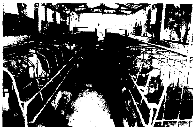
Khu chuồng lợn nái chữa xây mới tại trang trại 100 nái của ông Hồng Hoài Đức - Hà Tây
