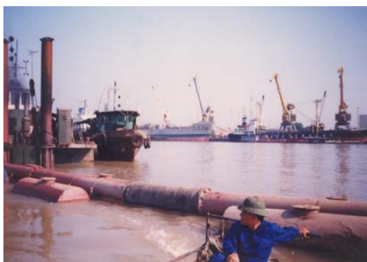
Sản phẩm ống đẩy chịu áp lực của Dự án được lắp đặt vào vị trí chịu áp lực cao nhất của hệ thống trên tàu HP1
