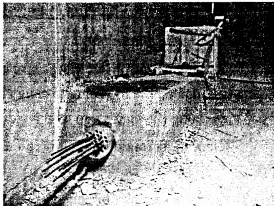
Hình 6 : Ví dụ cấu tạo ụ neo trong lòng dầm hộp để neo cáp chịu mô men dương đặt trong bản đáy hộp
