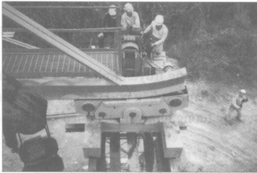
Hình 3.6. Tiếp cận mũi dầm vào đỉnh trụ
