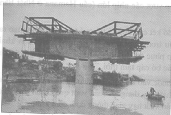
Hình 5.7. Thi công hẫng đối xứng cầu Phù Đồng
