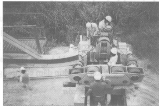
Hình 3.7. Tiếp cận mũi dầm vào đỉnh trụ
