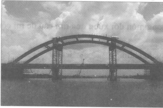
Hình 6.7. Cầu vòm làm bằng ống thép nhồi bê tông (đang thi công)
