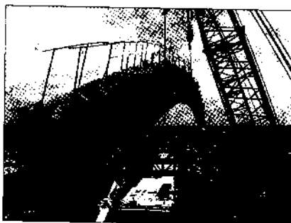
Hình 6.13. Lắp biên vòm tiếp theo
