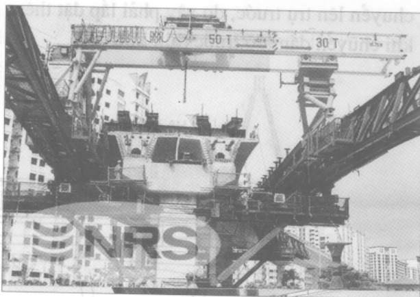
Hình 4.13: Cầu cổng chạy trên hệ đà giáo di động
