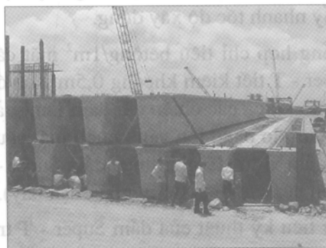
Hình 1.13. Xếp đầm sau khi đủ cường độ
