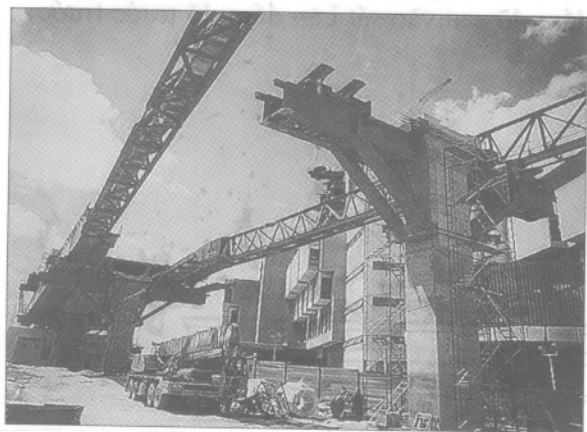
Hình 4.12: Giá đỡ công xôn, hệ đà giáo chạy dưới
