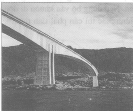
Hình 5.1. Cầu dầm hộp trên đường cong
