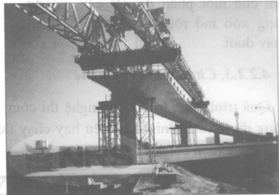
Hình 4.2.b: Hệ đà giáo chạy trên - Dầm đỡ trước đặt trên dầm chủ.
