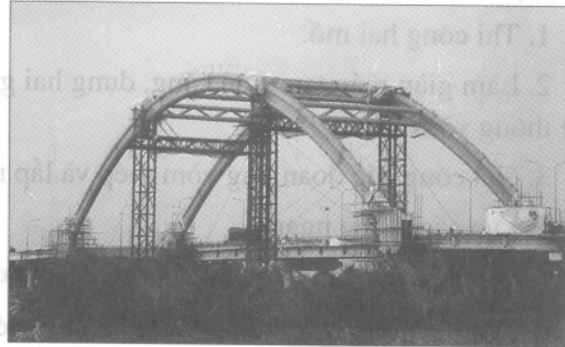
Hình 6.8. Cầu vòm làm bằng ống thép nhồi bê tông (đang thi công)
