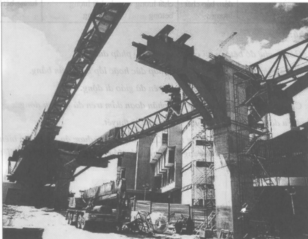
Hình 4: Công nghệ lắp ghép các phân đoạn dầm dưới đà giáo di động Các phân đoạn dầm đúc sẵn được lao lắp dưới hệ đà giáo di động
