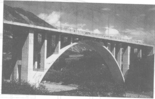
Hình 6.3. Cầu vòm chạy trên
