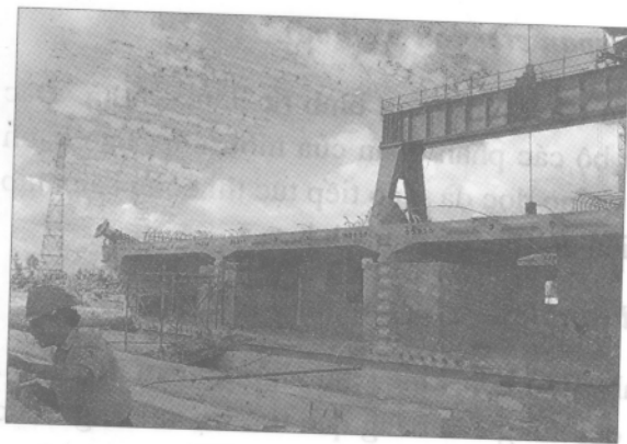
Hình 4.15. Đốt dầm đúc sẵn
