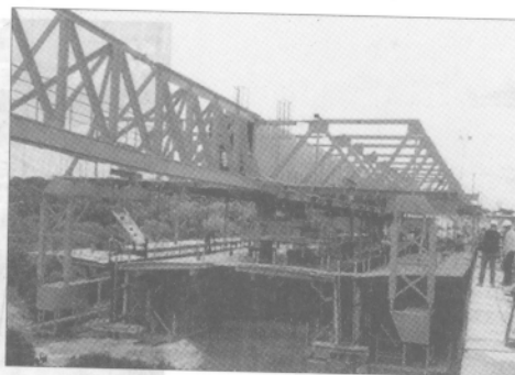
Hình 3.5. Hệ mũi dẫn cho loại chạy trên
