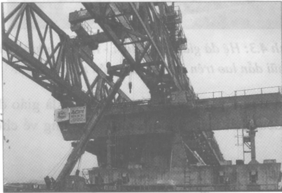
Hình 4.2.a: Hệ đà giáo chạy trên - Dầm đỡ trước đặt trên đỉnh trụ.
