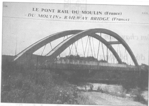
Hình 6.4. Cầu vòm đường sắt Dumoulin (Pháp)
