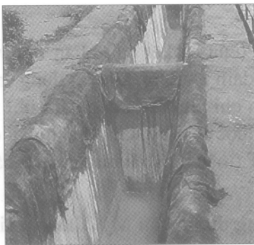
Hình 1.12. Bảo dưỡng đầm
