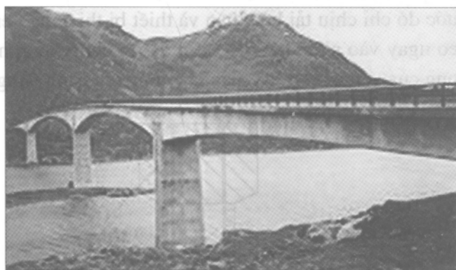
Hình 5.2. Cầu dầm hộp trên đường thẳng
