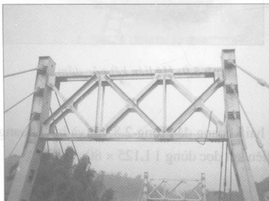
Hình 5.11: Hệ liên kết tháp cầu
