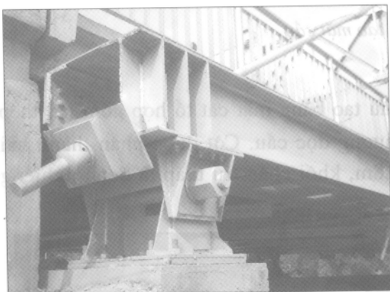
Hình 5.8: Cấu tạo dầm dọc
