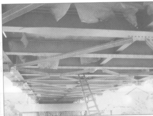
Hình 5.9: Hệ liên kết các dầm dọc
