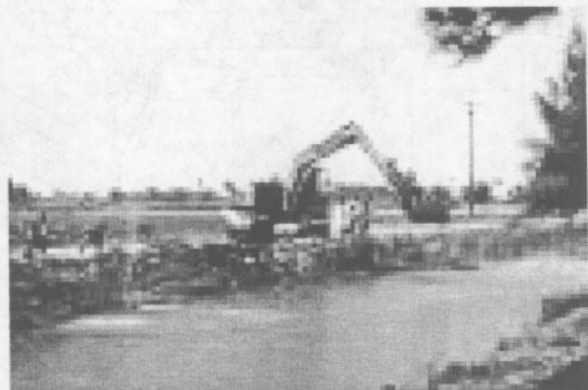
Hình 3.26: Thi công kênh đất
