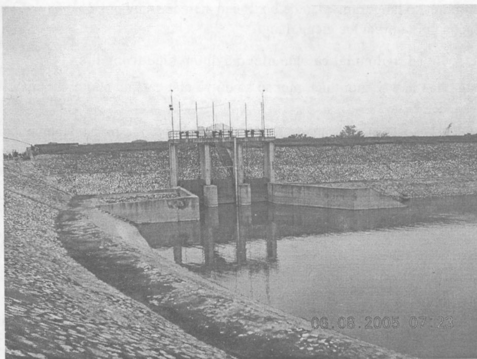
Hình 8.2: Bể xả của nhà máy bơm tiêu nước
