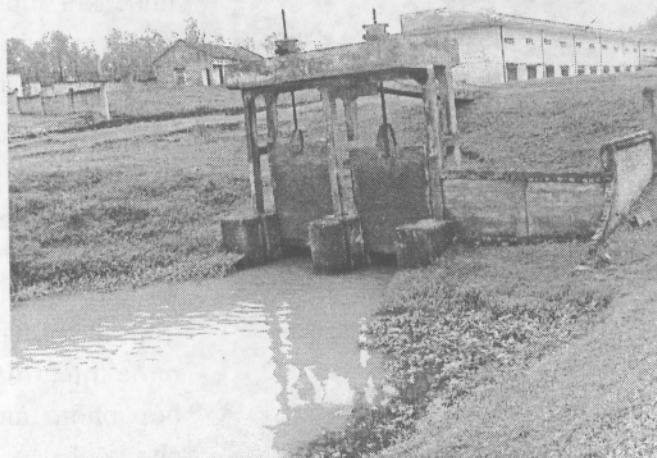
Hình 3.35: Cống lấy nước vào trạm bơm
