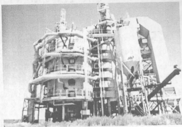
Hình 252: Đốt bằng lò đáy bằng nhiều tầng
