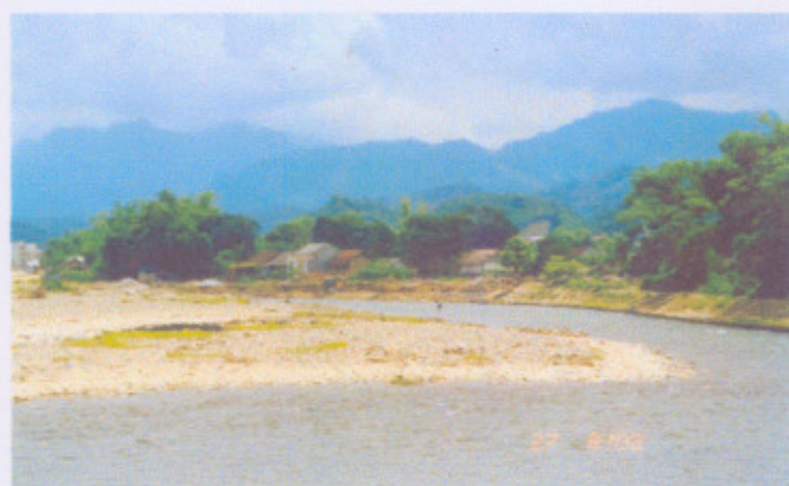
Ảnh 34 : Sạt lở bờ sông Cầu ở tx. Bắc Kạn (Đoạn sạt lở đang được thi công kè bằng rọ đá ). Ảnh Phạm Tích Xuân
