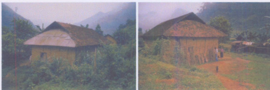
Ảnh 41 : Nhà ở của đồng bào H'Mông (xã Minh Tân, h.Vị Xuyên, t.Hà Giang) nền đất, tường được xây bằng sét phong hoá từ các đá có tính năng phóng xạ cao (Nồng độ radon trong nhà 1590\text{Bq/m}^3 , bức xạ gamma 50\text{ }\mu\text{R/h} )
