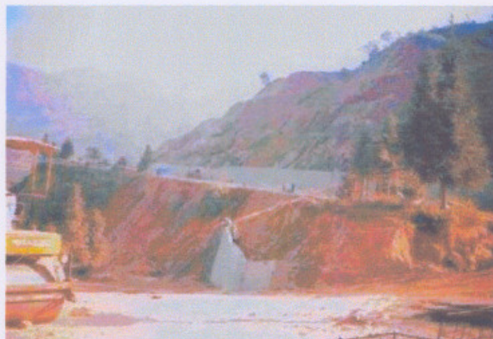
Ảnh 14 : Đại công trường xử lý trượt lở tại Km118 ÷ 119 (QL4D) năm 2003 (phía nam cầu Móng Sến, Sáp Pa, Lào Cai).
