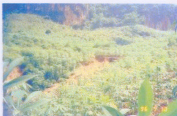
Ảnh 2 : Nứt đất khu vực Xóm Mỏ (Mai Châu, Hoà Bình)
