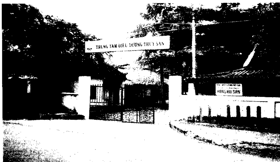
Trụ sở Trung tâm điều dưỡng thủy sản Sầm Sơn
