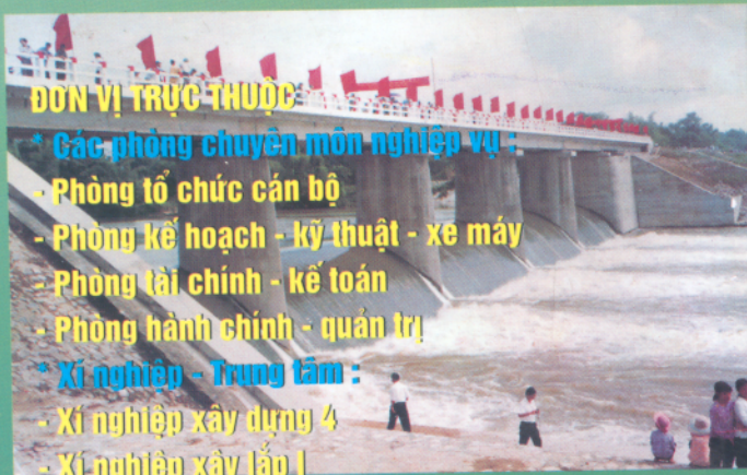
Công trình Đập Thác Huống - Thái Nguyên ▼
