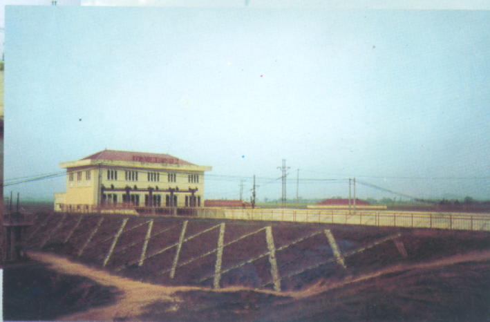
Trạm bơm Kim Đồi 2 - Bắc Ninh
