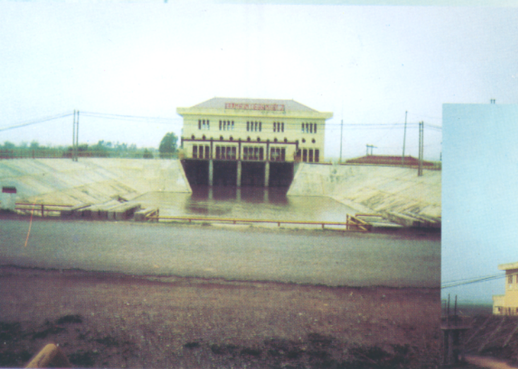
Bể xả Trạm bơm Kim Đồi 2 - Bắc Ninh
