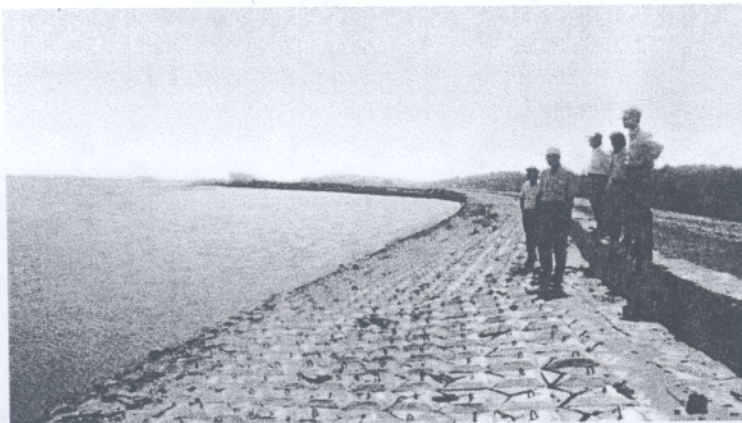
Kè đê biển Gò Công Đông Tỉnh Tiền Giang Cấu kiện P.Đ.TAC-178
