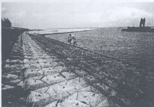
Kè đê biển Hải Hậu Tỉnh Nam Định Cấu kiện P.Đ.TAC-178
