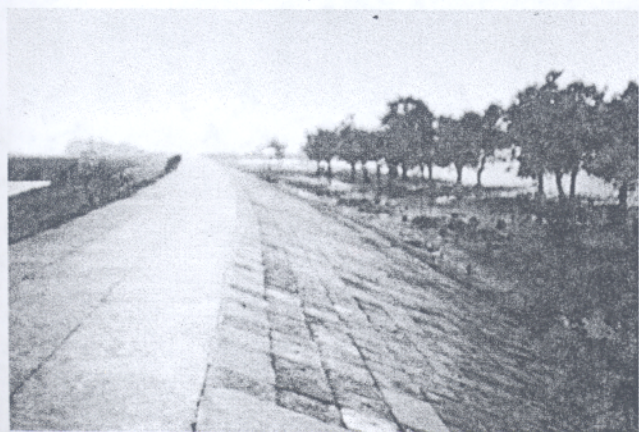
Kè Đê sông Tỉnh Quảng Bình Cấu Kiện P.Đ.TAC-HI 0099
