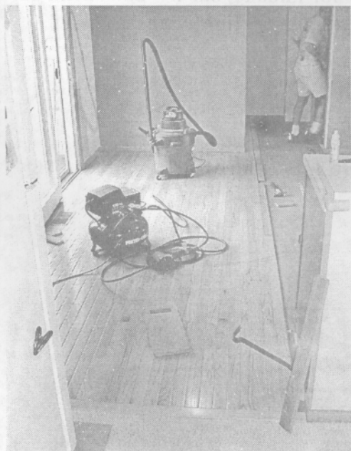
Lắp đặt mặt sàn gỗ nhân tạo
