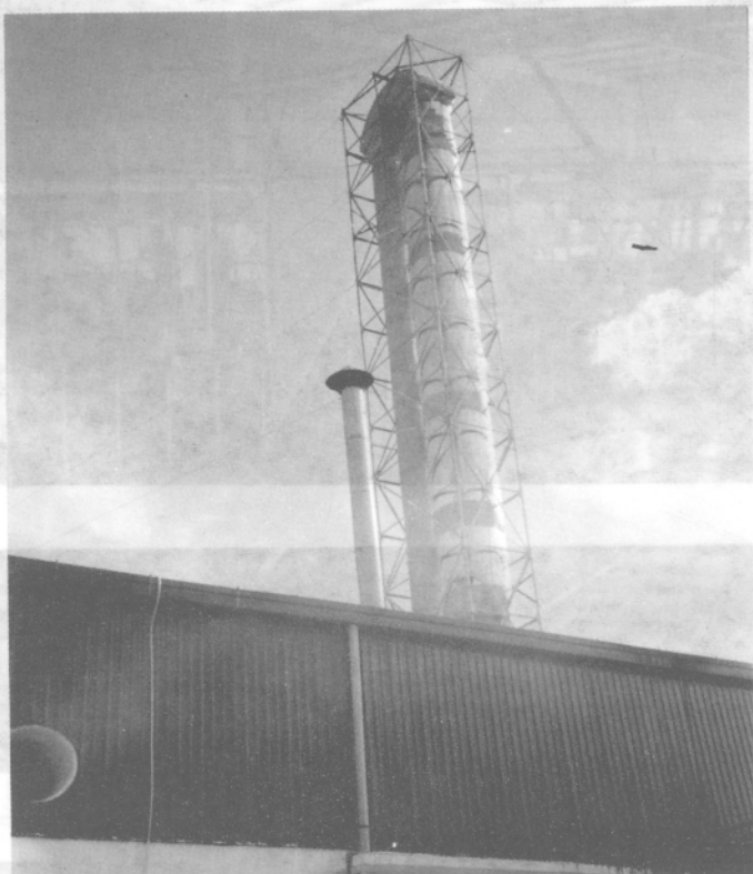
Hình 11: Tháp sấy khí động trong nhà máy sản xuất tinh bột sắn
