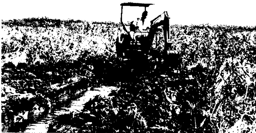
Hình 7. Lên liếp tại vùng đất phèn Tây Nam Bộ bằng máy đào PC-12
