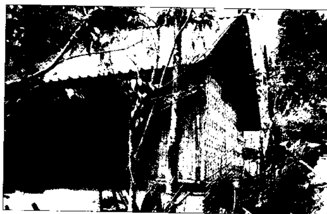
Hình 1: Mái nhà ở Bản Hồ
