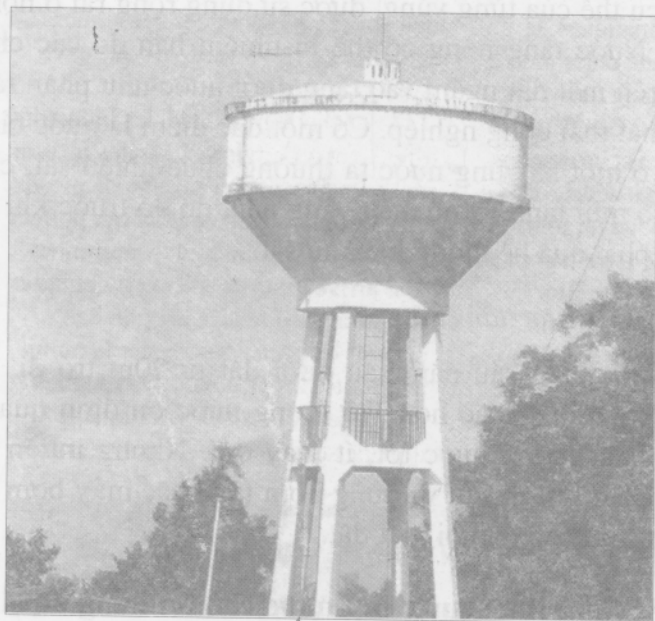
Hình 4. Bể chứa nước xây cao
