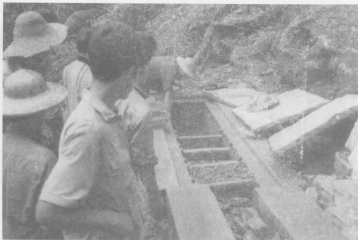
Hình 10. Xây bể lọc của hệ thống dẫn nước từ khe suối miền núi
