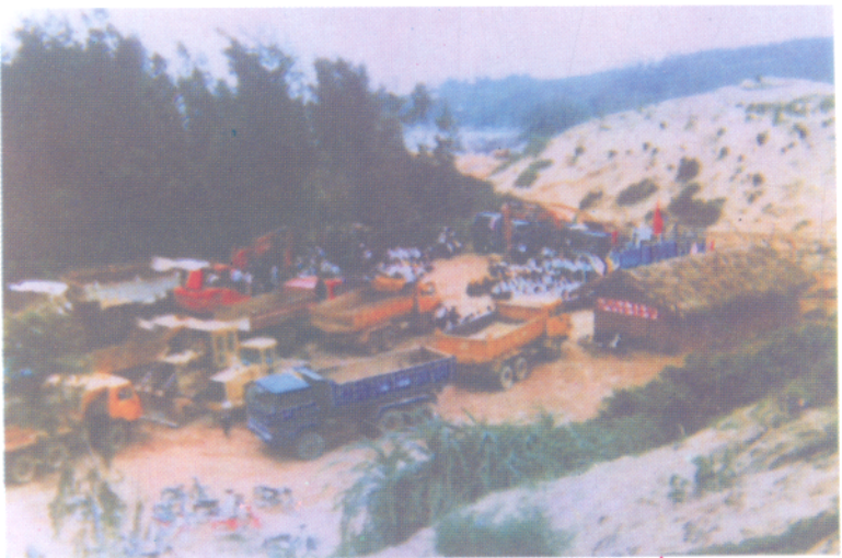
Lễ khởi công xây dựng bến số 1 cảng Dung Quất
