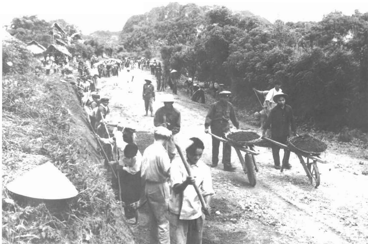
Công nhân Việt Nam cùng bộ đội và nhân dân Lào thi công đoạn đường Mường Liệt (từ Na Mèo đi Sầm Nưa), năm 1963 ກຳມະກອນຫວຽດນາມ ພ້ອມກັບທະຫານ ແລະ ປະຊາຊົນລາວ ສ້າງທາງ ເມືອງລຽດ (ຕອນແຕ່ນາແມ້ວ ໄປຊຳເໜືອ), ປີ 1963 Vietnamese workers and Lao soldiers and people building the Muong Liet Road (from Na Meo to Sam Neua), 1963
