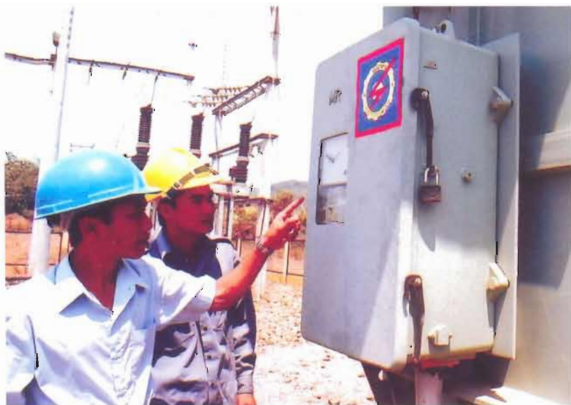
Công nhân Việt Nam - Lào trao đổi kinh nghiệm vận hành tại Trạm biến áp Densavăn (Lào), năm 2001
