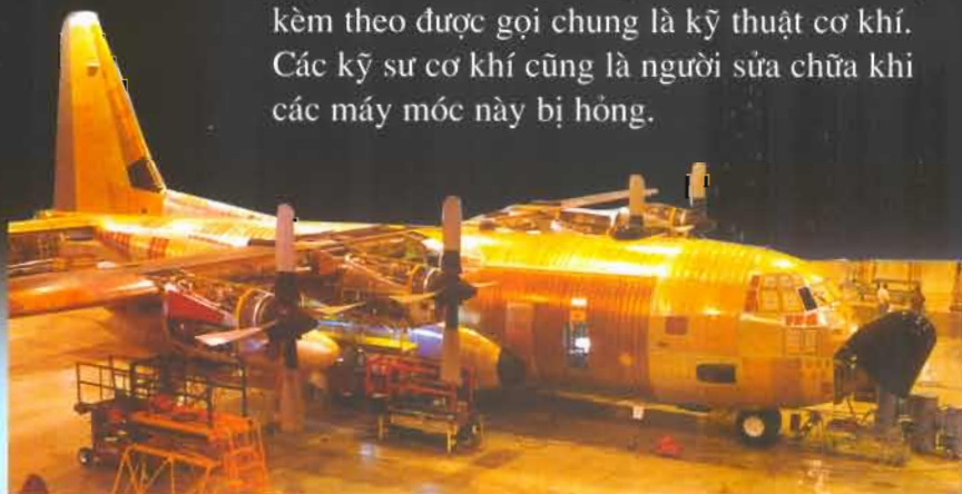
Xưởng sản xuất máy bay.
