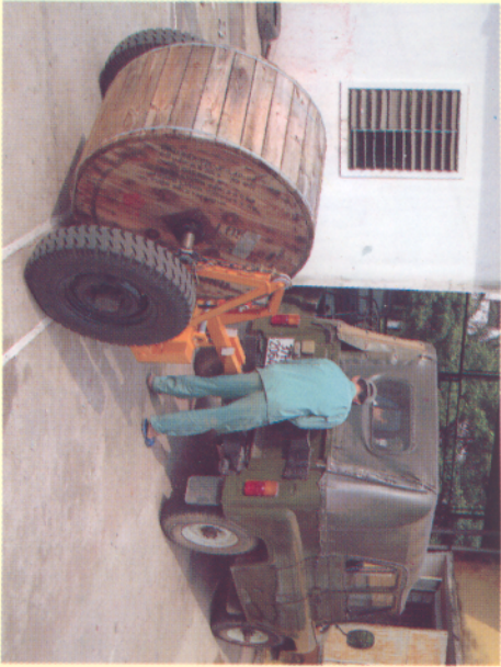
Thực hiện ra cáp bằng ô tô kéo
