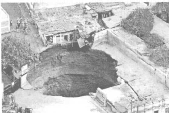
Hình 6.13: Hố sụt đất khổng lồ tại thành phố Guatemala ngày 23-2-2007
