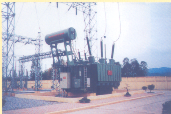
Máy biến áp 220 kV do Công ty cổ phần Chế tạo thiết bị điện Đông Anh chế tạo với sự hỗ trợ KH&CN theo Nghị định 119/1999/NĐ-CP
