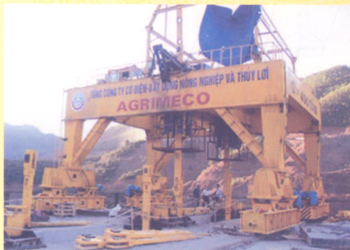
Hệ thống xi lanh thủy lực của AGRIMECO được lắp đặt tại Thủy điện Sơn La - Một sản phẩm có sự đóng góp quan trọng của Chương trình KC.05
