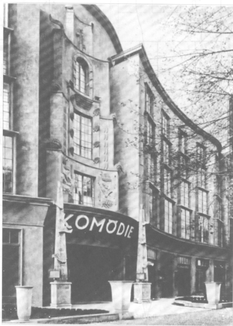
C17. Nhà hát Kurfürstendamm (xây dựng năm 1928 - 800 chỗ) và Nhà hát hài kịch (xây dựng năm 1924 - 400 chỗ) kề nhau. KTS. O.Kaufmann. Trùng tu năm 1971 - 1972. KTS. S.Kressmann - Zschach Berlin (Đức)
