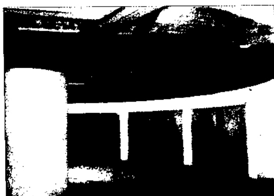
L22. Sân khấu quay kiểu đĩa, trục cố định. Bánh xe ở mâm quay, đường ray ở sân khấu.
