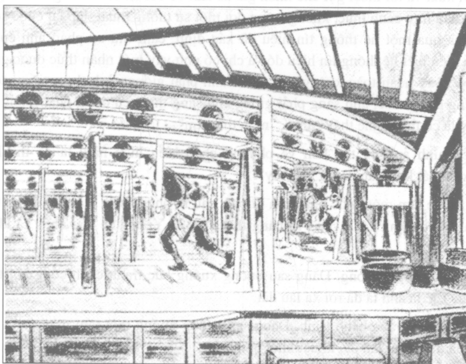
Hình 42. Sân khấu quay nhà hát Kabuki quay bằng sức người
