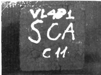
Hình 3.6: Bề mặt bị nứt của mẫu sử dụng xi măng CA50 và sỏi cuội
