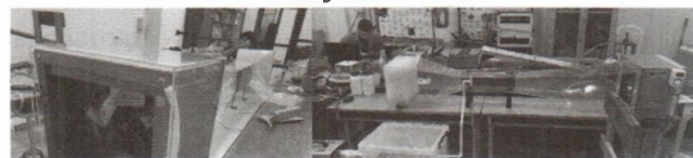
Hình 2.5: Chế tạo và lắp quạt, lắp hoàn chỉnh hầm gió
