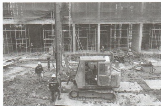
Hình 1.1a: Thi công cọc khoan nhỏ đường kính nhỏ ở Việt Nam
