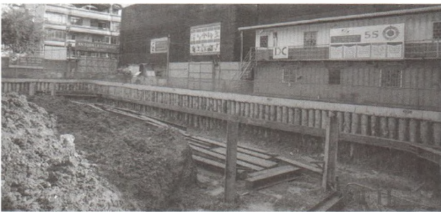
Hình 1.1d: Sử dụng cọc khoan nhồi đường kính nhỏ làm tường chắn đất trên thế giới
