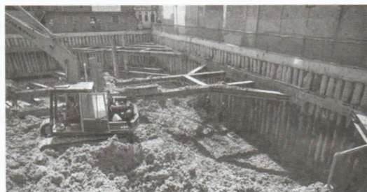
Hình 1.1b: Sử dụng cọc khoan nhỏ đường kính nhỏ làm tường chắn đất ở Việt Nam
