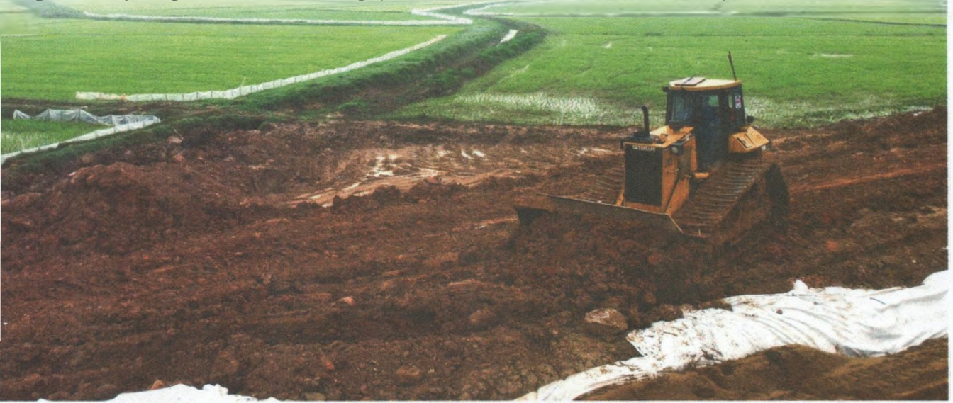
Thi công cao tốc Diễn Châu - Bãi Vọt trên tuyến cao tốc Bắc - Nam
