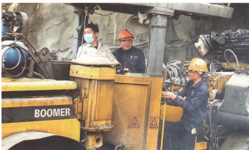
Công nhân thi công hạng mục khoan hầm Thung Thi, cao tốc Mai Sơn - QL45 trên tuyến cao tốc Bắc - Nam
