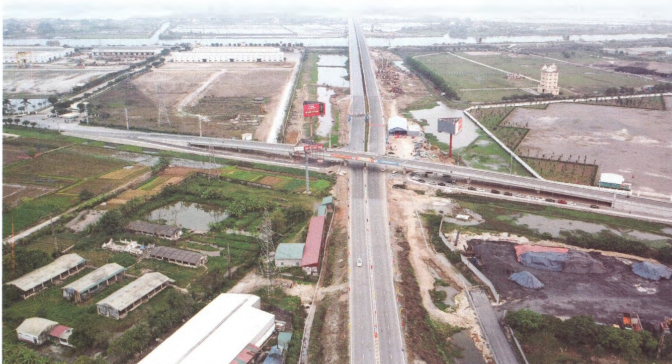
Cao tốc Bắc - Nam đoạn Cao Bô - Mai Sơn hoàn thành đưa vào khai thác đầu năm 2022
