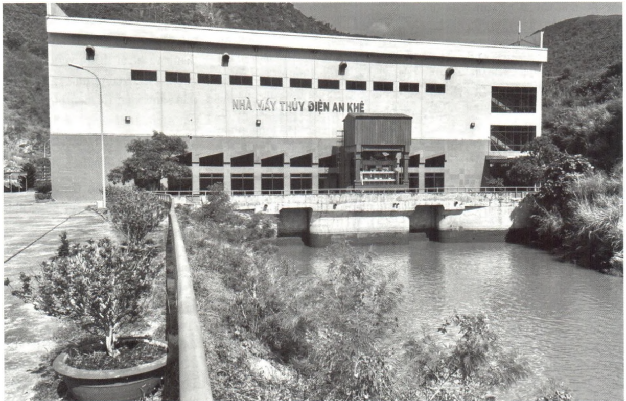
Nhà máy Thủy điện An Khê.
