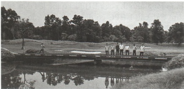
Hình 3. Đoàn công tác Hội bê tông Châu Á thăm quan cầu UHPC tại Hà Nội
