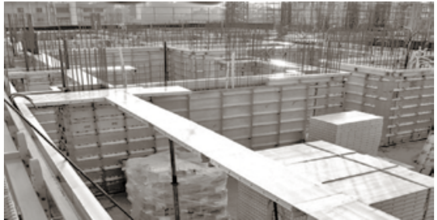
Hình 1.1. Hình ảnh thi công ván khuôn nhôm tại dự án Hyundai HillState
