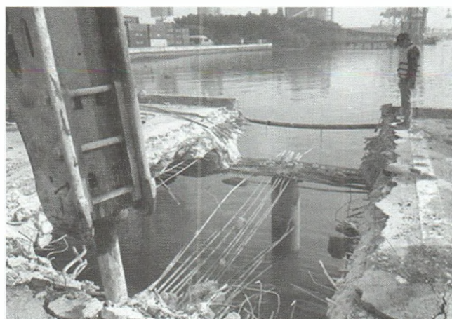
Hình 3.1: Công tác phá dỡ bản mặt cầu và đầm để thí nghiệm PDA cọc C1 và C2 [2]
