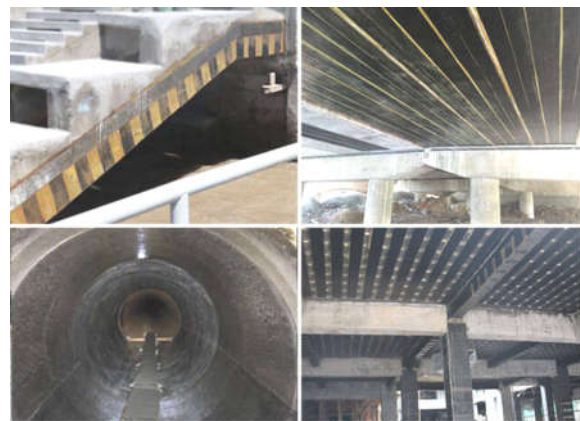
Hình 3. Sử dụng tấm CFRP gia cường các kết cấu (Sanghai Hourse Construction Co., Ltd)
