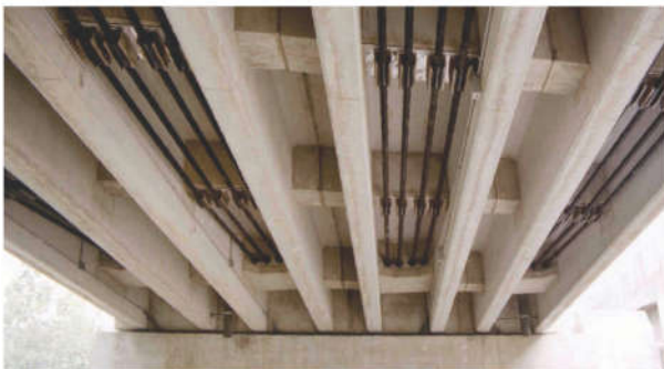
Hình 7. Cầu Bridge Street-Mỹ (Tokyo Rope)
