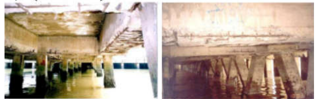
Hình 8a-b. Hư hỏng của kết cấu bê tông cốt thép ở Hải Phòng (trái) và Vũng Tàu (phải) (Đặng Vũ Tuấn và Lê Hoàng Hà (2013))
