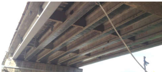
Hình 9. Gia cường dầm chủ cầu Cồn Tiên thuộc tỉnh An Giang (Công ty JV teck)
