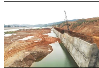
Hình 5. Thi công tường kè sườn chống bản góc BTCT bờ hữu sông Hồng - Thành phố Lào Cai
