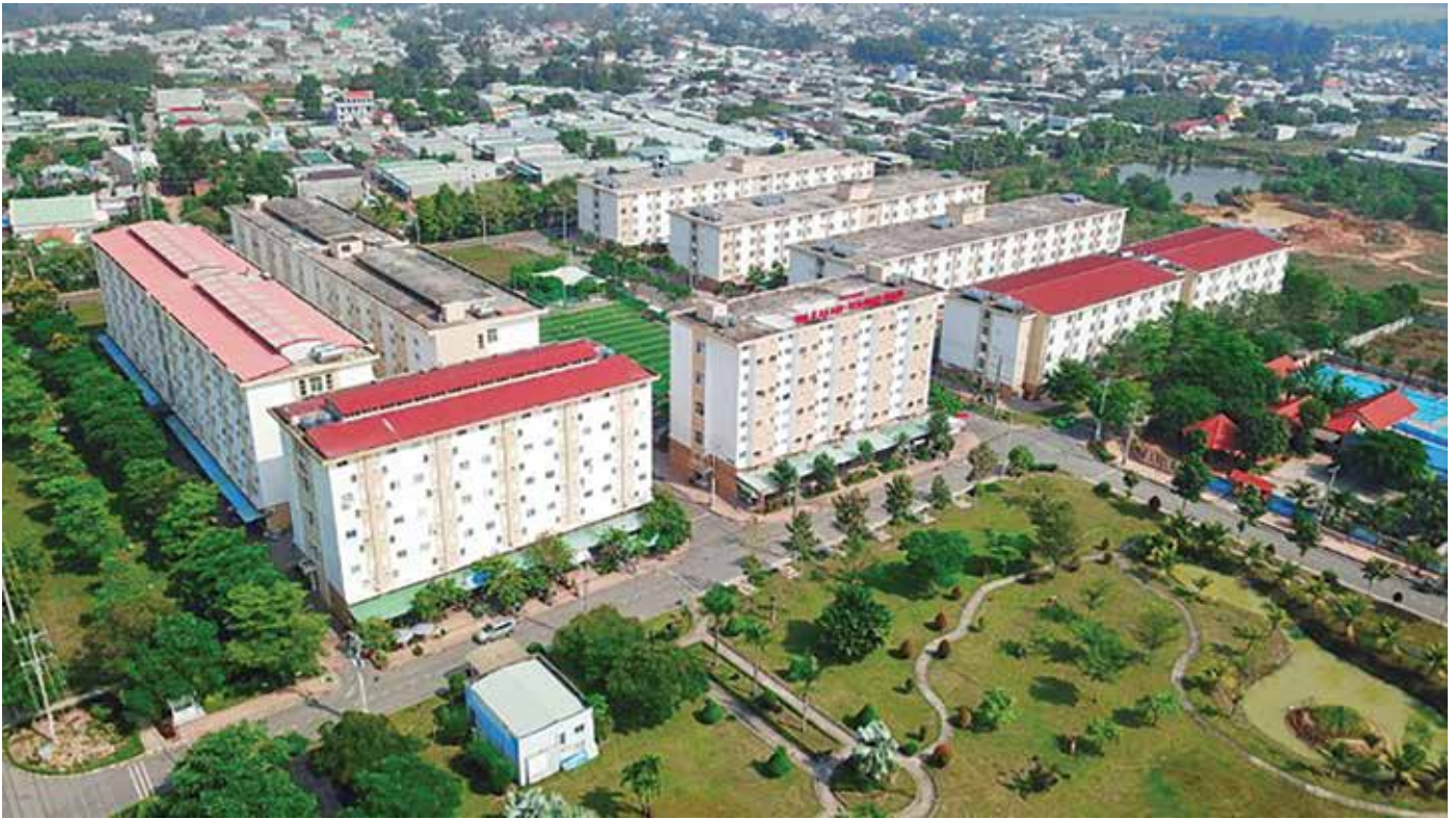
Khu nhà ở công nhân KCN Nhơn Trạch do IDICO xây dựng từ năm 2013.
