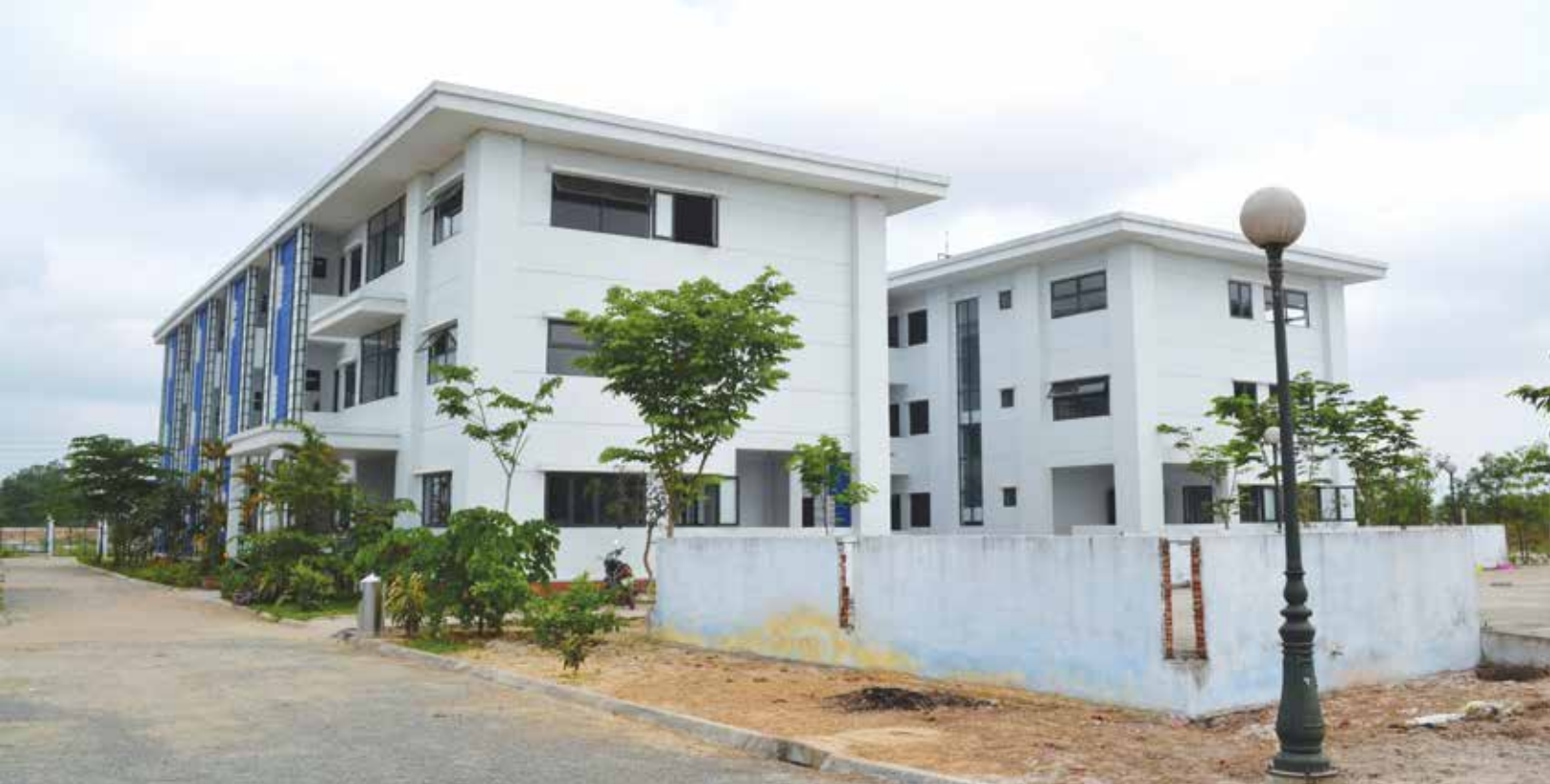
Nhà ở cho công nhân tại các KCN Phong Điền do Công ty TNHH Scavi Huế làm chủ đầu tư.
