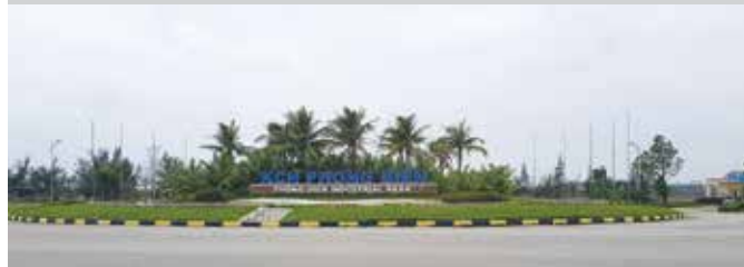
Khu kinh tế và các KCN trên địa bàn tỉnh Thừa Thiên - Huế thu hút hàng nghìn công nhân lao động, nhưng nhà đầu tư chưa mặn mà đầu tư nhà ở cho công nhân.
