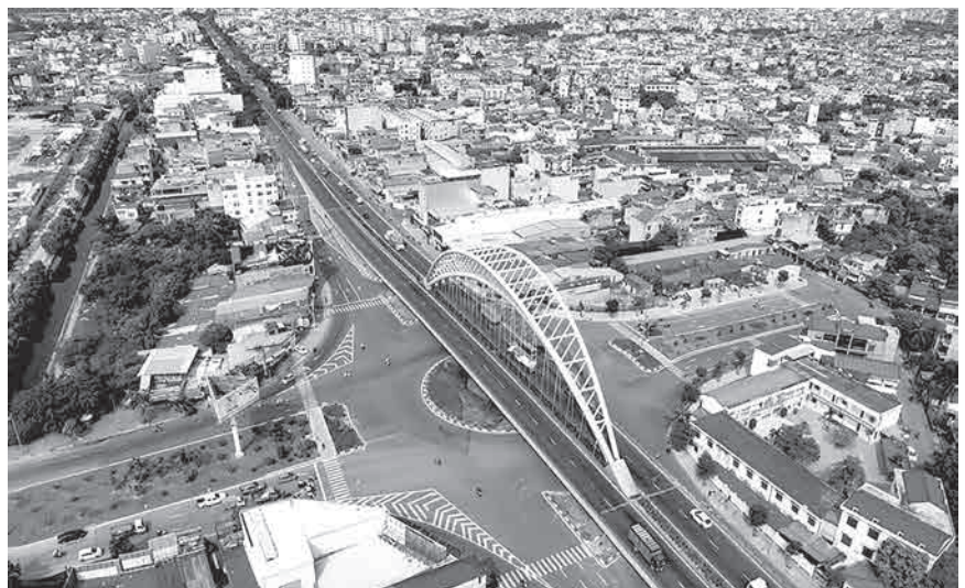
Công trình cầu vượt Nguyễn Văn Linh nút giao thông Ngã 3 Cầu Rào 2
