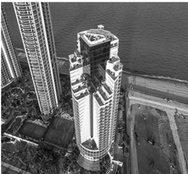
Hình 9- Green roof giạt cấp bậc thang
