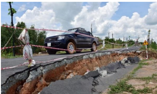
Đường cấp kênh Gò Thuyền (Long An)
