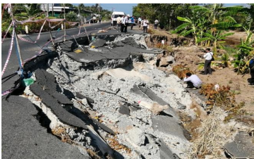
Tuyến đường Tắc Thủ - Vàm Đá Bạc (Cà Mau)
